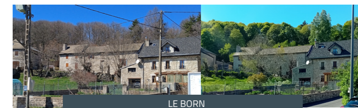
LE BORN Avant/Après travaux d'enfouissement
