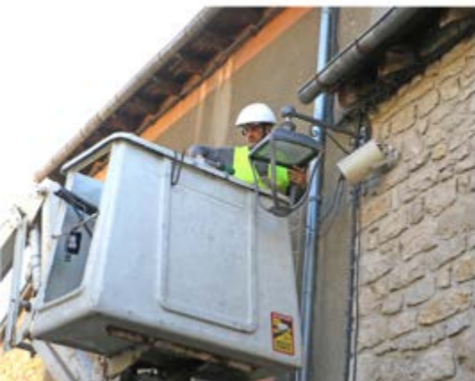
▲ Dépose et remplacement des luminaires au sein du village. PHOTO DR
