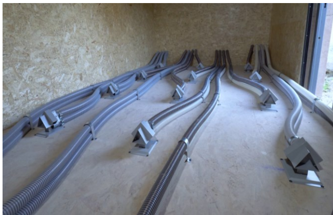
Bouches d'aspiration à l'intérieur du silo
