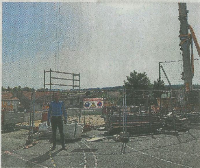
Un énorme chantier pour améliorer la restauration du lycée.
