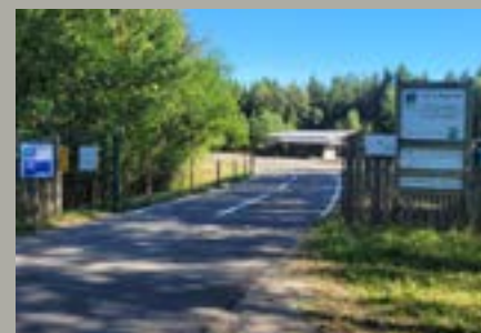
*Installation de Stockage de Déchets Non Dangereux
