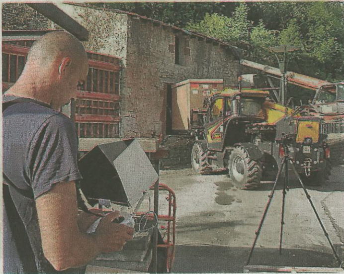
La mise en service est prévue en octobre.
