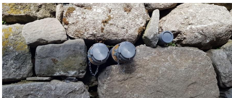
Les bouches de remplissage du silo
