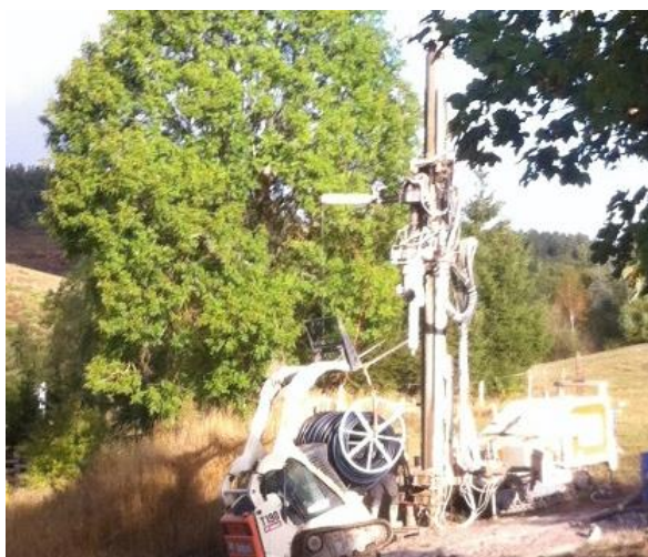
Réalisation des forages à proximité du futur bâtiment
