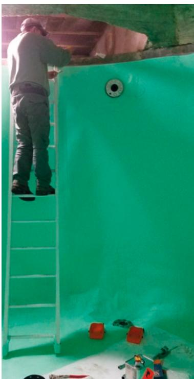
Pose d'une membrane d'étanchéité dans le réservoir de Ville Haute (Cubières)
